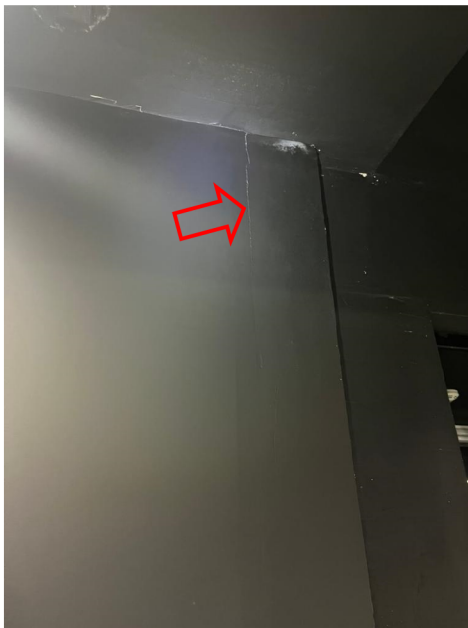
Fot. 22. Zarysowanie pionowe ściany oddzielające pomieszczenia na balkonach.
