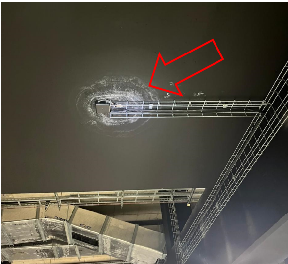
Fot. 10. Widok zawilgocenia na spodniej części konstrukcji stropodachu.
