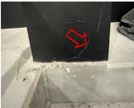
Fot. 19. Widok zarysowania tynku na słupie u jego podstawy.
