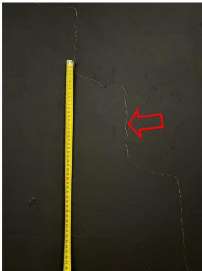
Fot. 18. Widok rysy ukośnej na ścianie.
