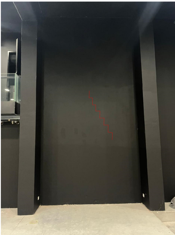
Fot. 17. Widok na ścianę z zaznaczeniem rysy.
