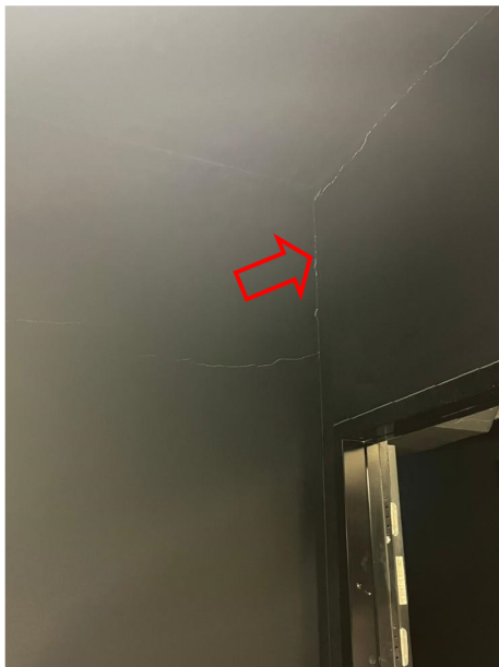
Fot. 23. Zarysowania pionowe i poziome ścian działowych balkonów.
