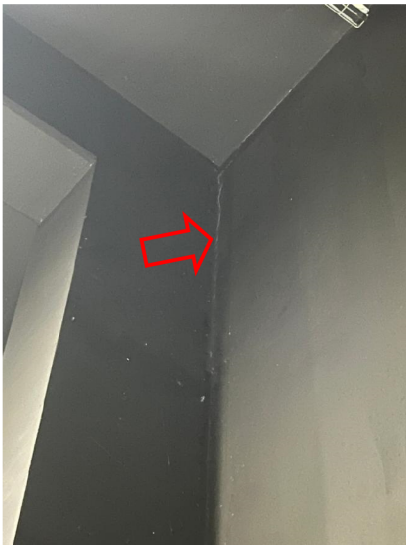
Fot. 20. Widok zarysowania na połączeniu ściany i słupa u jego góry.
