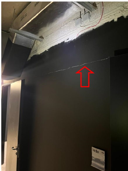
Fot. 24. Zarysowanie poziome pomiędzy ścianą a podciągami stropodachu.
