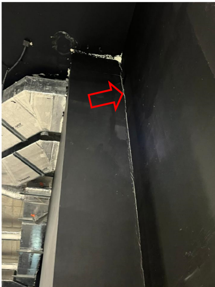
Fot. 21. Widok zarysowania pomiędzy słupem a ścianą w ich górnej części.
