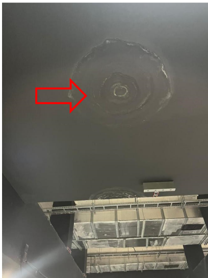
Fot. 7. Widok zawilgocenia na spodniej części konstrukcji stropodachu.
